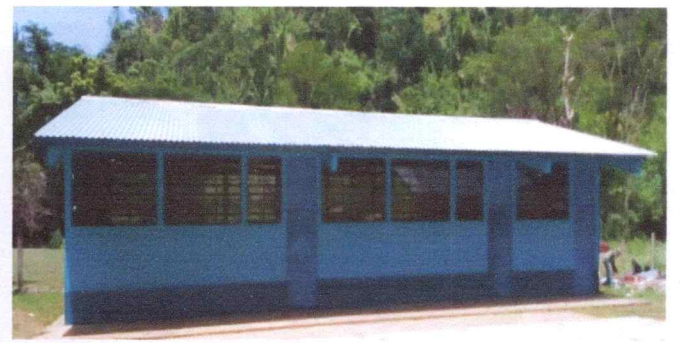
Foto 4: se observa en la fotografía la pintada de las puertas y con su respectiva chapas nuevas.
